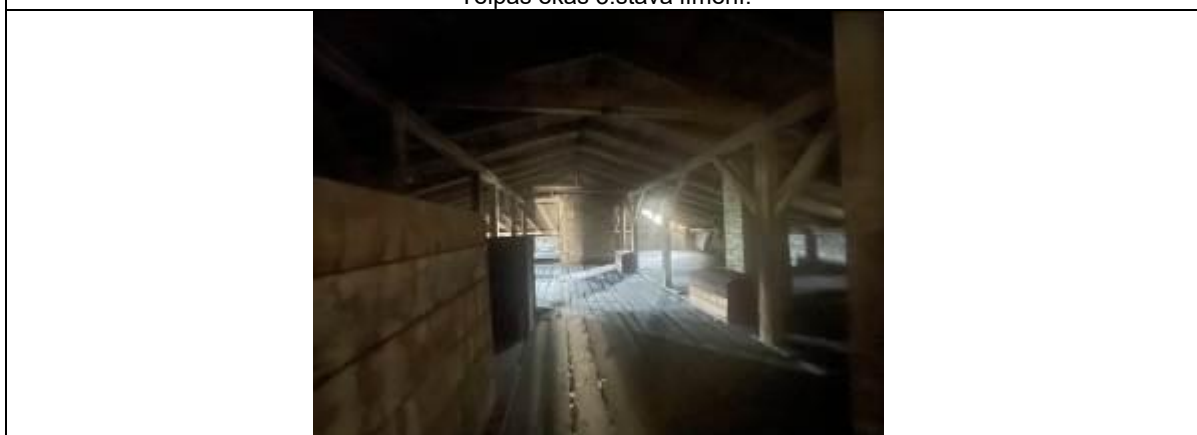
Ēkas bēniņu stāvs.
