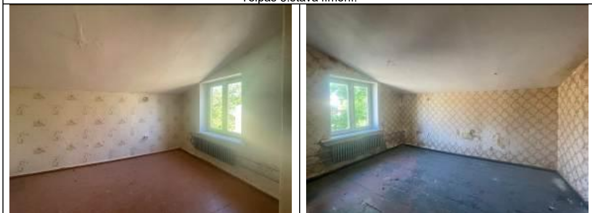
Telpas ēkas 3.stāva līmenī.
